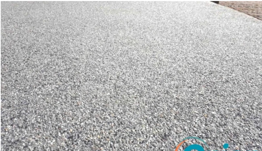
Eqiom luxembourg sa beton
