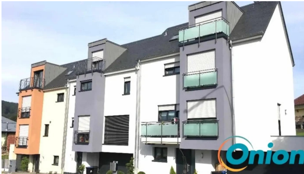
Siebenaller constructions mersch
