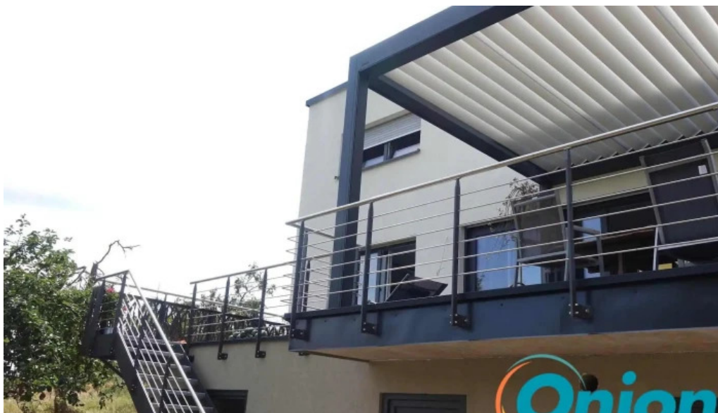
Renocon sarl renovierung anbau umbau und aufstockung aussenbereich
