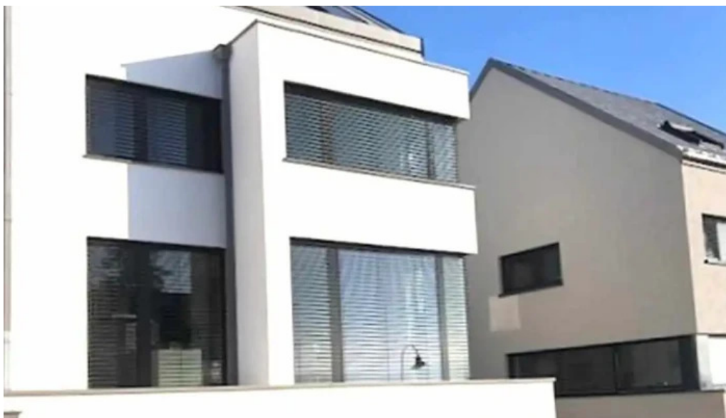
Luxtim sarl beton
