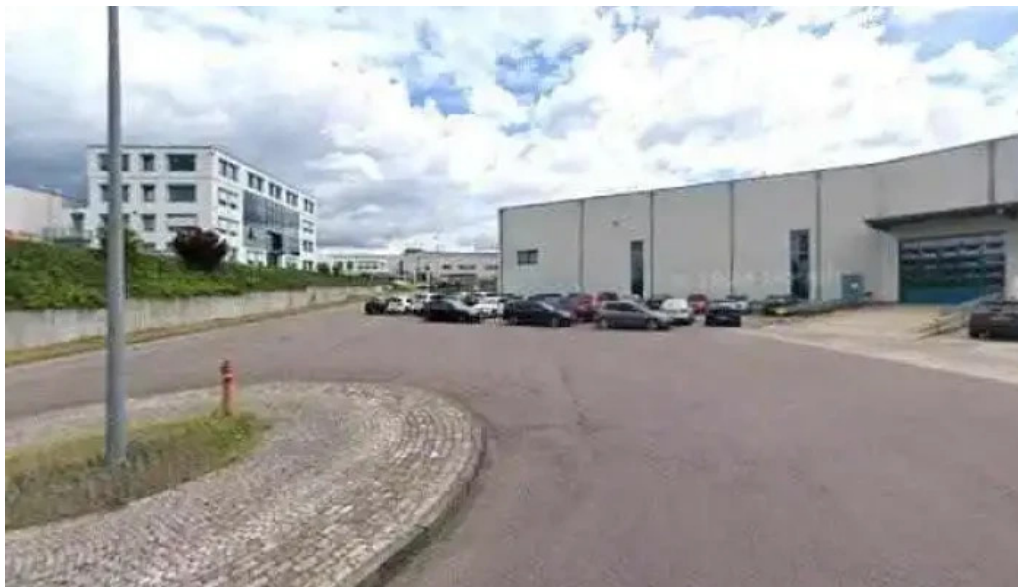
L elenz gmbh co kg strassenbau kanalbau hochbau bewaertungene
