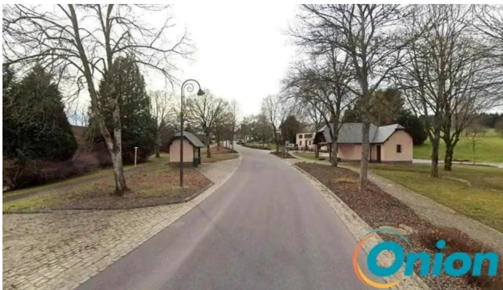
Qualiconstruct sa sa winseler
