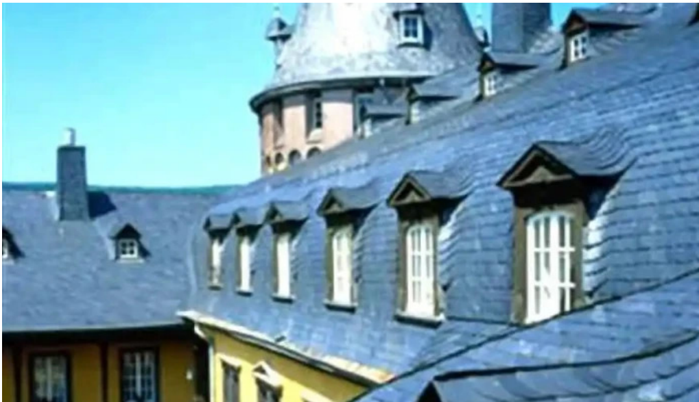
Toiture generale nilles fils sarl haus
