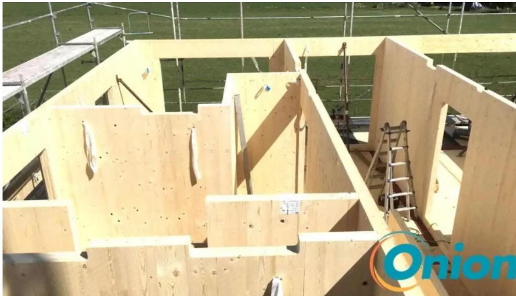
Weyer zimmerei holzbau sarl vom inhaber
