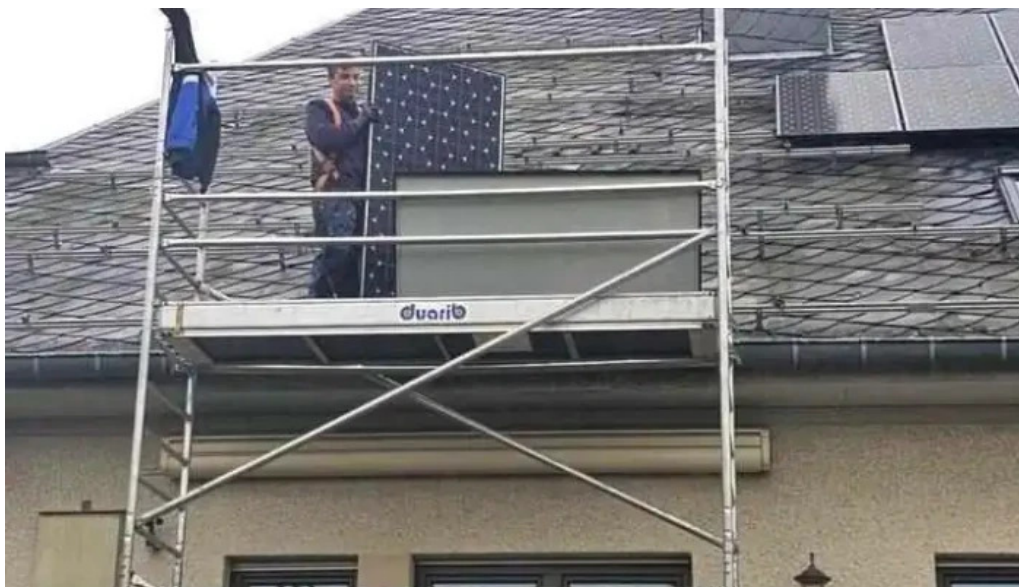
Pm toiture neueste
