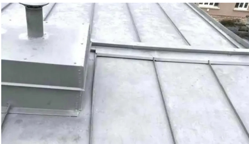
Pm toiture haus
