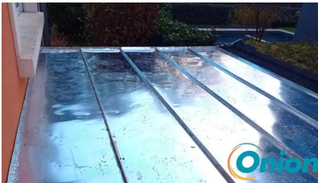
Pm toiture innenansichten
