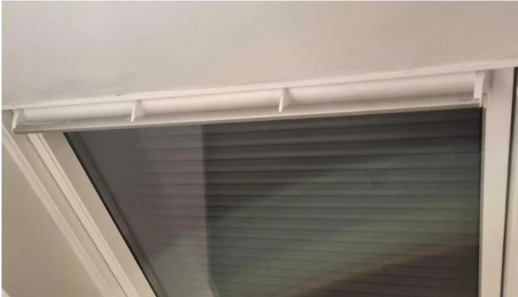
Toitures goerens sarl bewaertung
