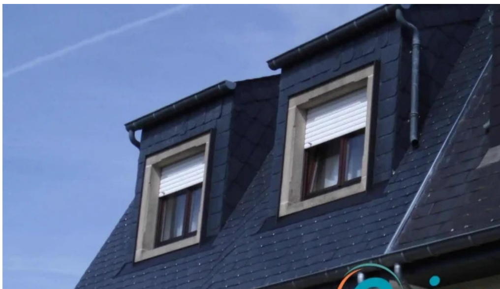
Entreprise de toiture gonalcalves dachschindel
