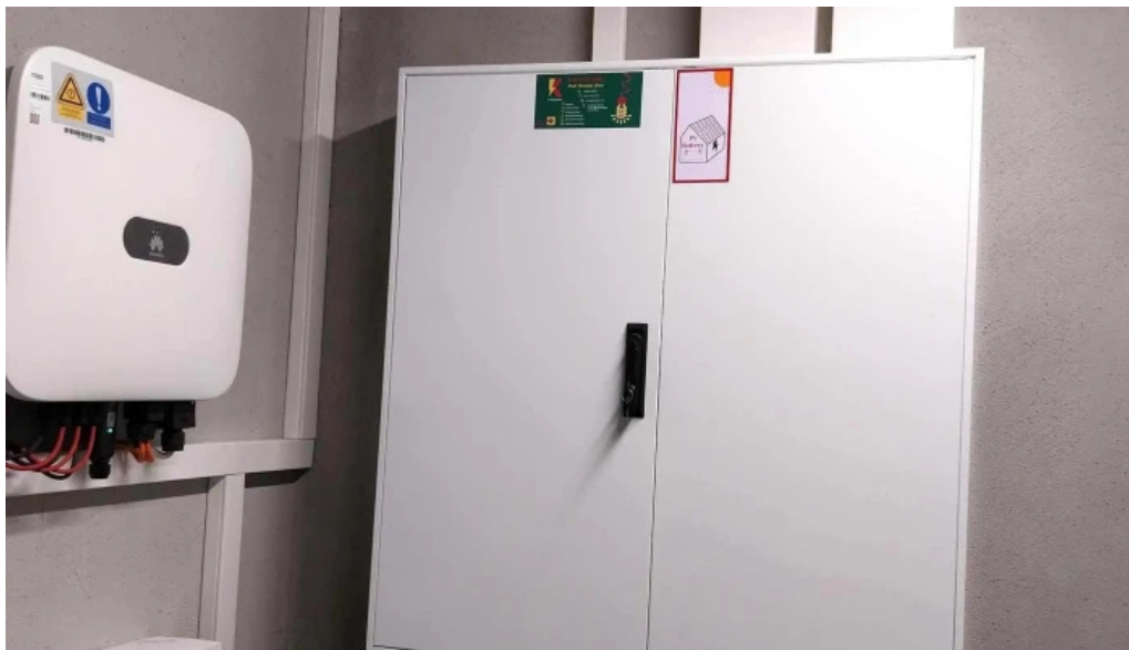
Electricite k electric websait
