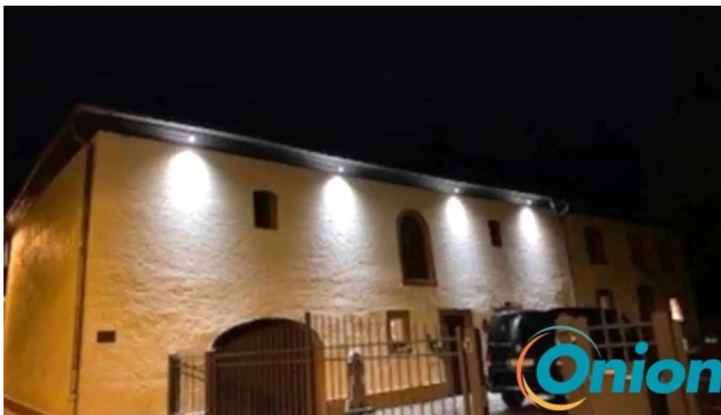
Entreprise d electricite biesen stauseegemeinde
