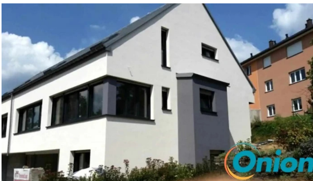
Ponistralux schaul sarl stonnenplange
