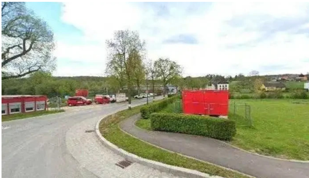
Centre d'incendie et de secours manternach kataloge
