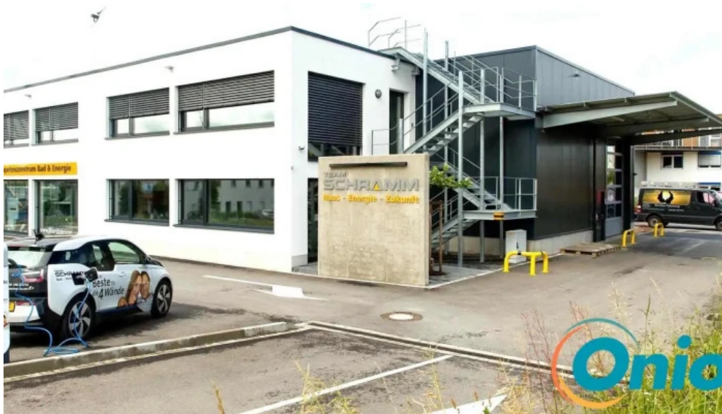
Team schramm sarl heizung warmepumpe photovoltaik badezimmer luftung bad mondorf
