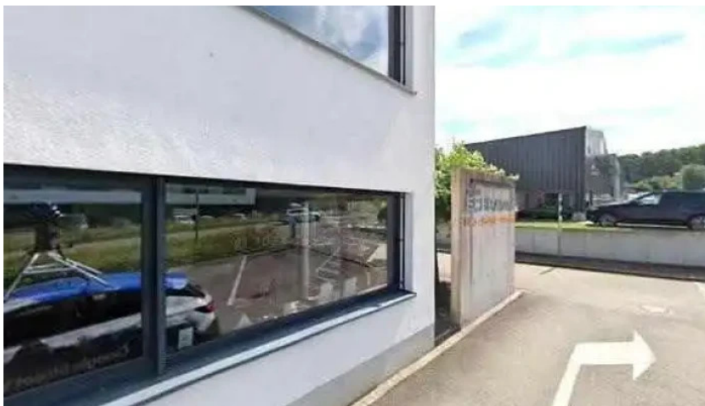
Team schramm sarl heizung warmepumpe photovoltaik badezimmer luftung street view 360deg fotos
