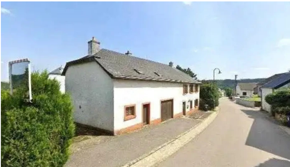
Chauffage sanitaire n kimmel sarl street view 360deg fotos
