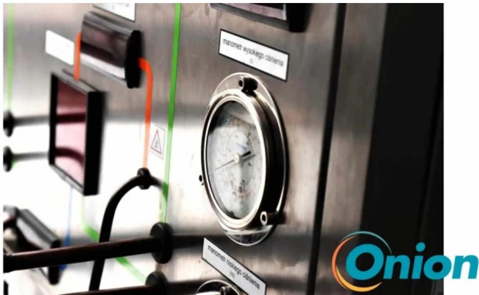
Rk chauffage sanitaire climatisation sarl wei do ukommene
