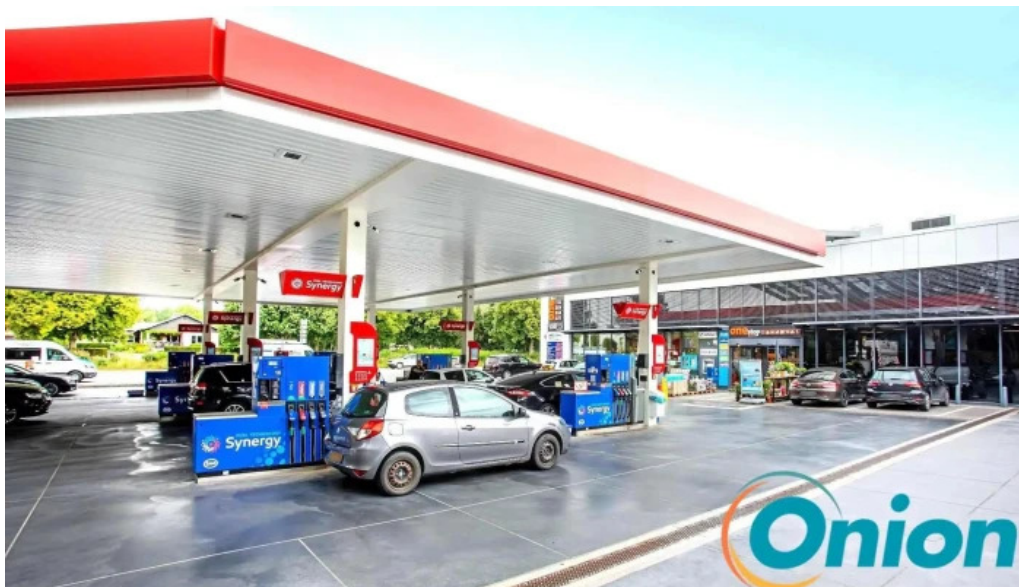
Bestcharge ladestation websaite
