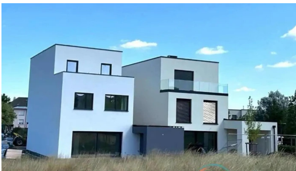
Lux ams sarl facades et renovations adresse
