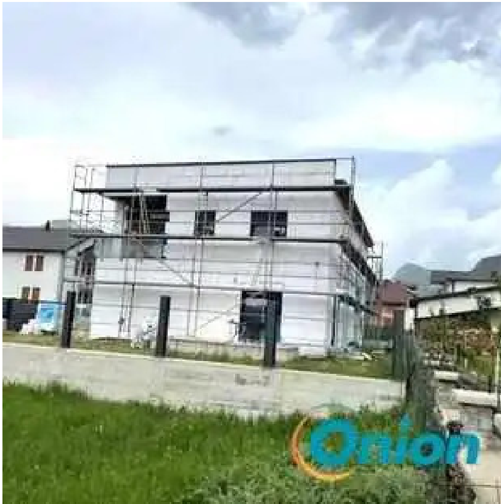
MI construction sarl aussenbereich
