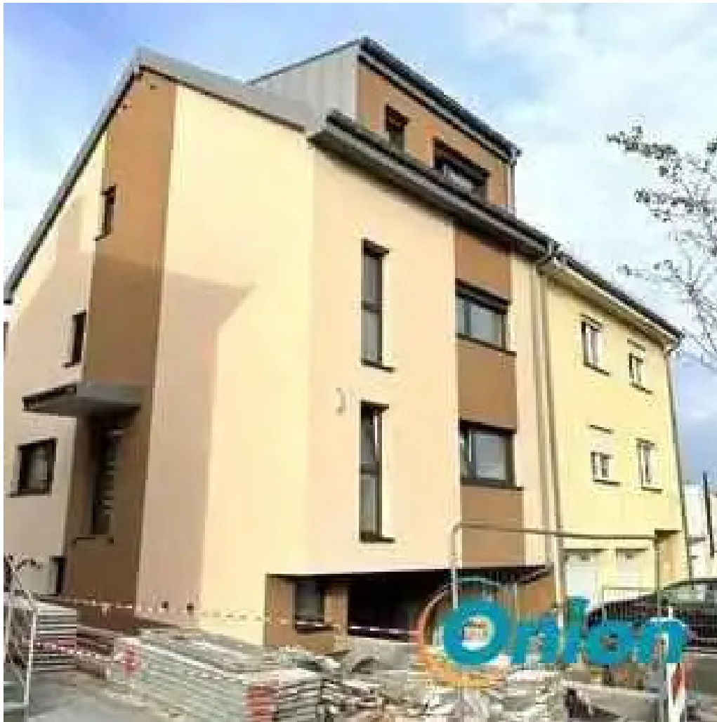
MI construction sarl petange
