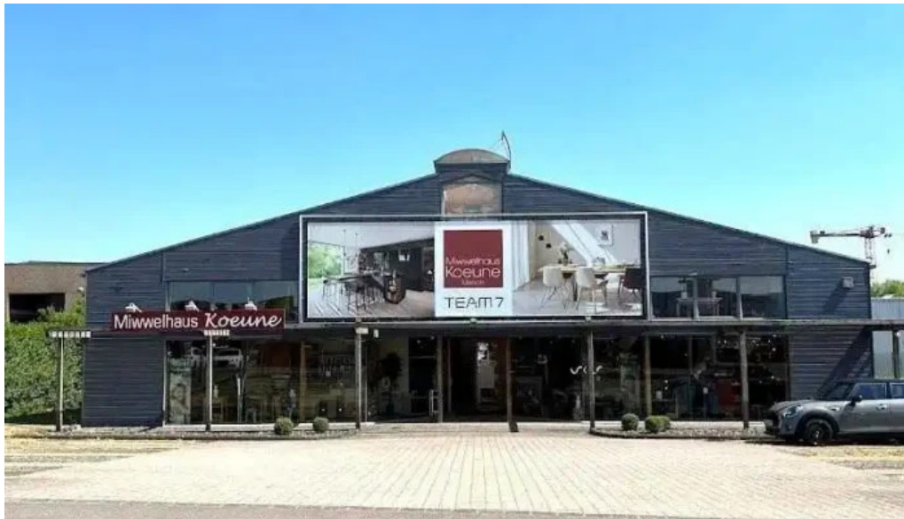
Miwwelhaus koeune mersch
