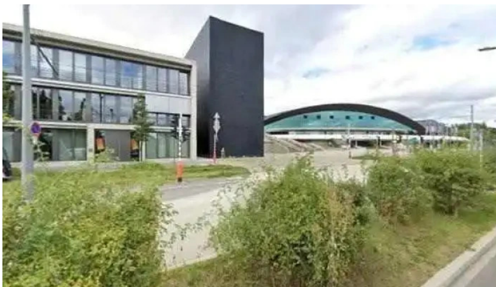
Luxenergie sa street view 360deg fotos
