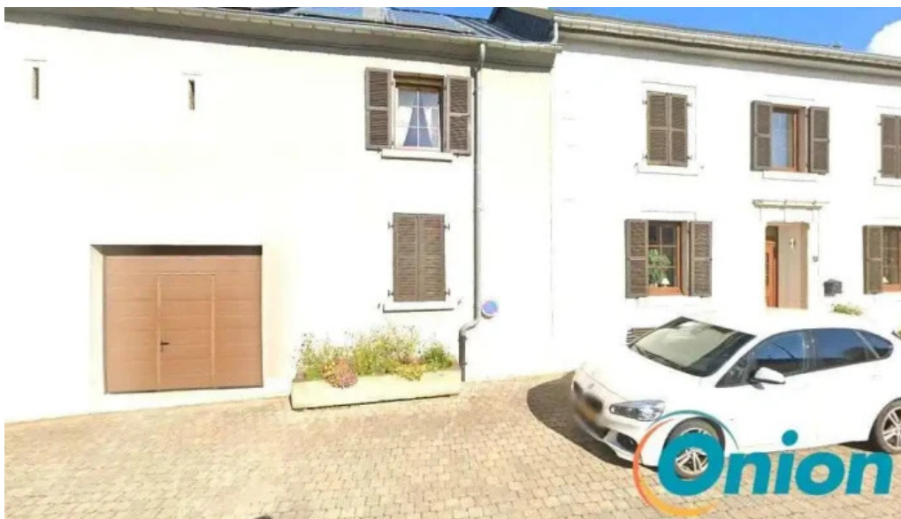
Clement sarl chauffage sanitaire rambruch
