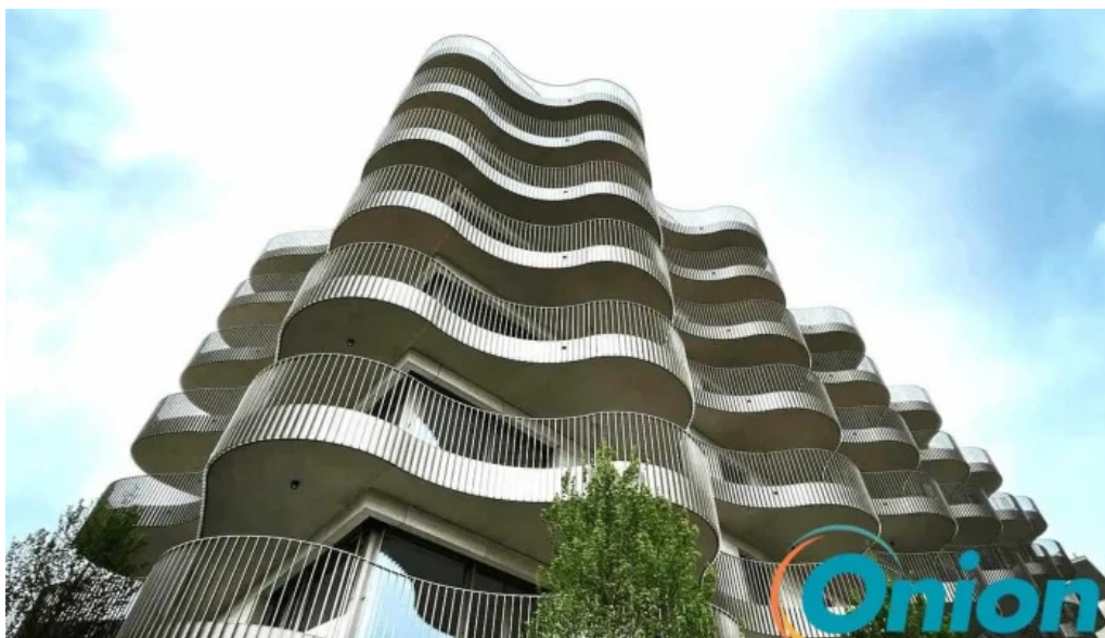
Fior ateliers sarl anciennement constructions metalliques guy gardula et associes sa kaerjeng
