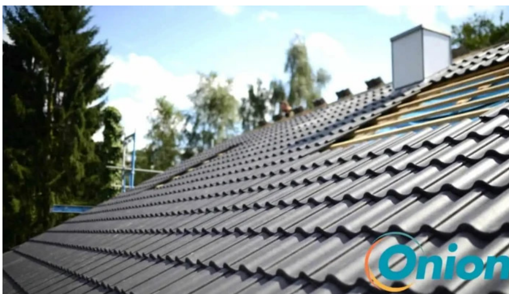
Toiture jamais sans toits sarl kaerjeng
