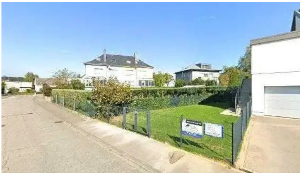
Toiture jamais sans toits sarl street view 360deg fotos
